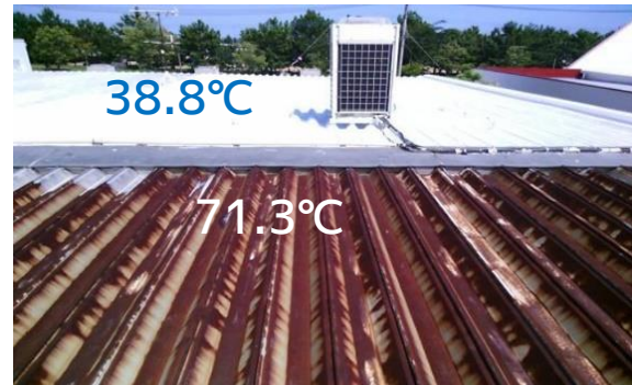
折板屋根断熱塗装あり・なし
